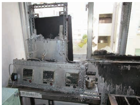
火災発生時に稼働していた 小型電気炉
