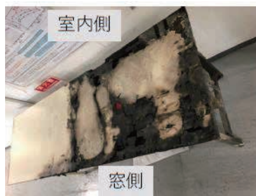
火元と推測される機材が載っていた 軽量作業台
