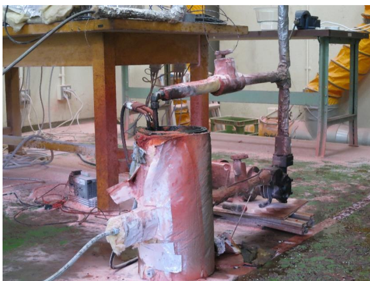
電気ヒーターで油を加熱していた容器（消化活動後）
