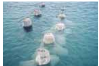
還元スラグと鋳物灰を大量に用いて製造したコンクリート製消波ブロック
