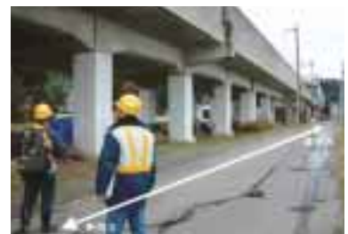
耐震補強してあった上越新幹線の高架橋(妙見トンネル付近)は全く被害がなかった。
