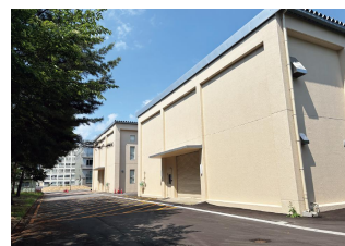
技術開発センター 1号棟と 2号棟の外観
