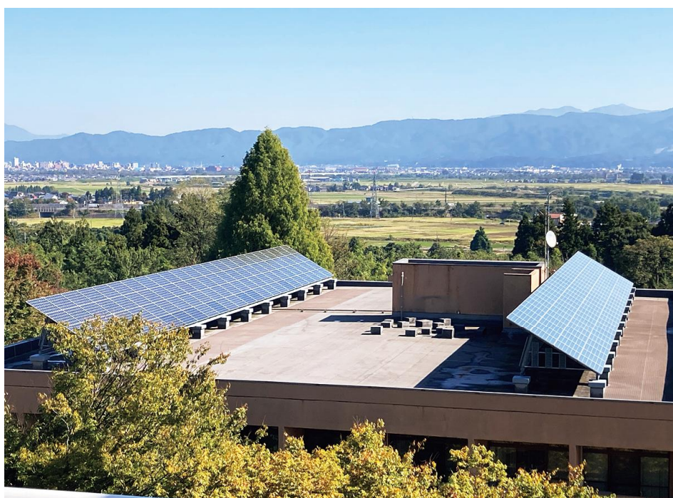
附属図書館屋上に設置の太陽光パネル
