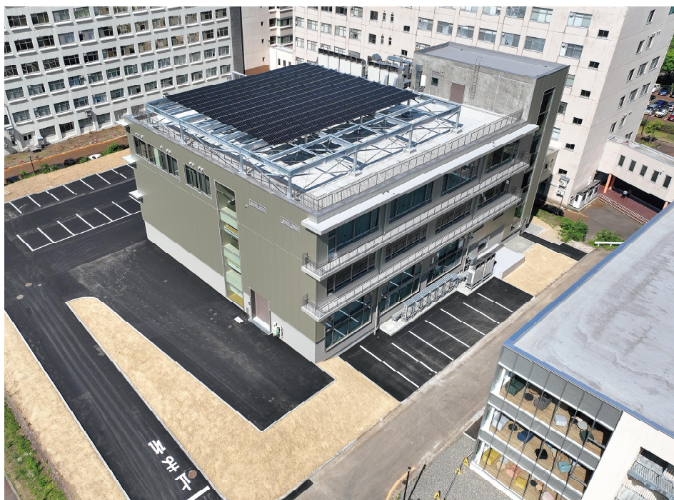
GX棟屋上に設置の太陽光パネル
