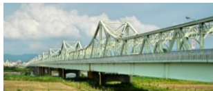
長生橋(ゲルバートラス橋)
