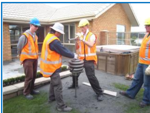
地盤調査 (ニュージーランド地震) : 力仕事です
