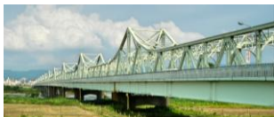
長生橋(ゲルバートラス橋)
