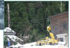
倒木による停電の復旧作業
