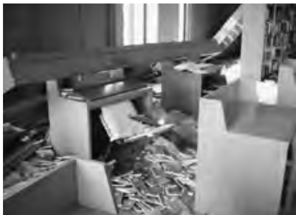
写真：転倒した書架（3階閲覧室）
