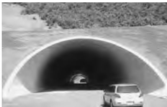
施工管理を行ったトンネル
