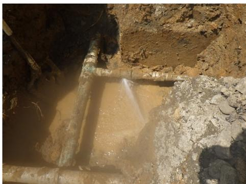
事故原因：屋外給水管の老朽化による漏水事故
