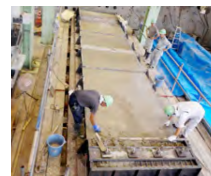
試験体準備(コンクリート打設)
