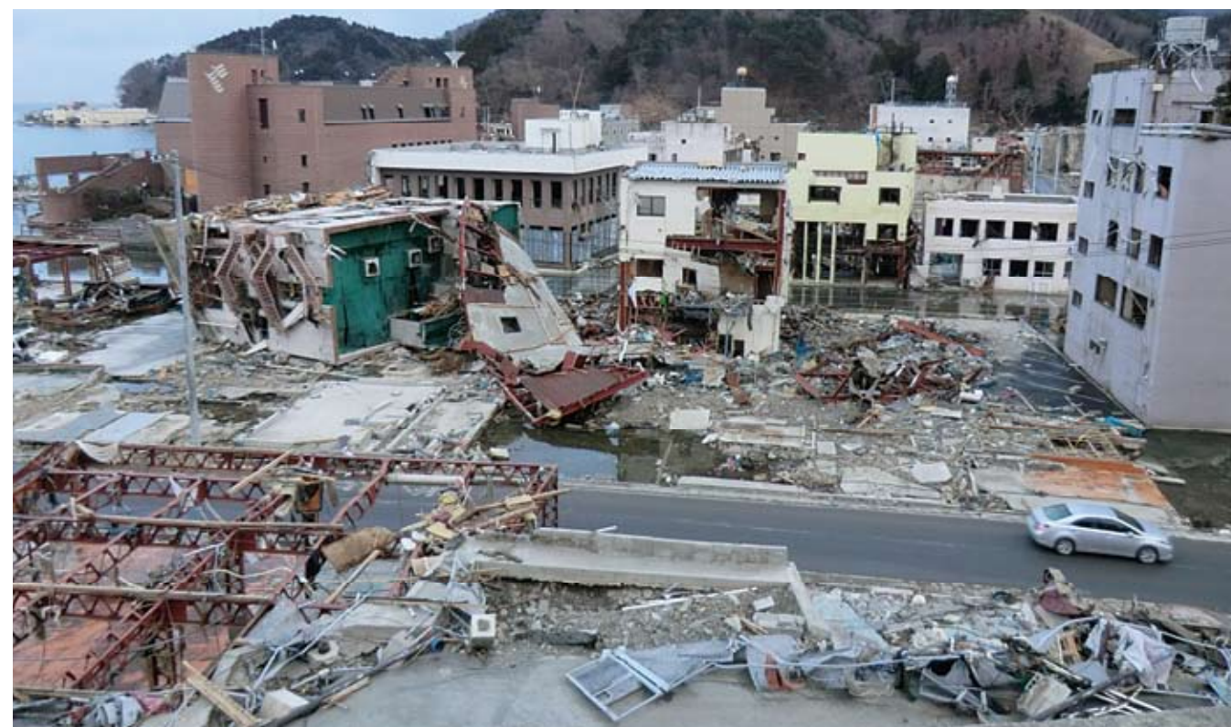
津波で破壊された建物(女川町)
