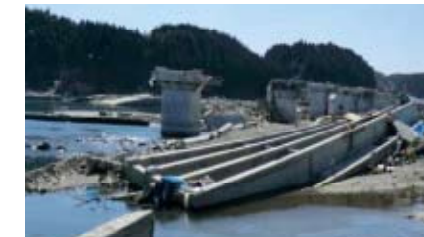
津波で落下したコンクリート桁(歌津大橋)
