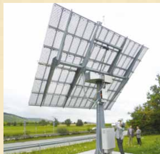
▲ CPV システムの例（独 Soitec Inc. にて著者撮影）
