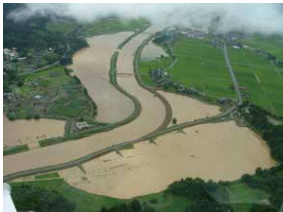
写真2 平成23年7月の水害における刈谷田川遊水地の状況（新潟県提供）
