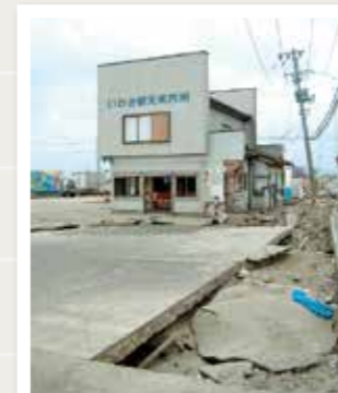
写真1 小名浜地区の地震と津波による被害
