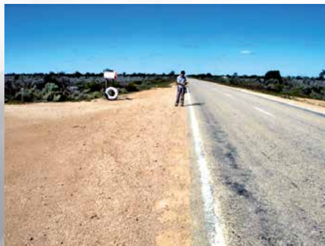
▲衛星データによる地図作成のための基準点測量(オーストラリア南西部)
