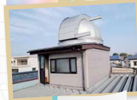
屋上に設置した観測室
