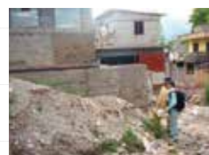
◀ 2005年バクスタン・カシミール地震における土石流被害の調査状況
