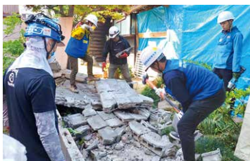
▲ブロック塀撤去
