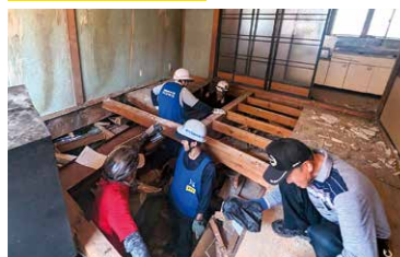
▲荷物運びだし現場
