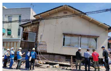
▲荷物運びだし現場
