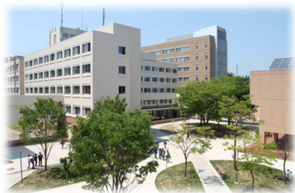
耐震工事や太陽光パネル取付を行った 長岡技大の建物
